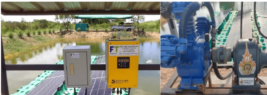
ภาพที่ 2 ภาพระบบการทำงานและวัสดุอุปกรณ์ของระบบเติมอากาศด้วยพลังงานแสงอาทิตย์ ขนาด 3 กิโลวัตต์
