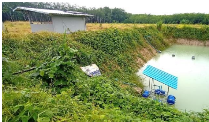
ภาพที่ 6 การใช้งานระบบสูบน้ำแบบแพลอยน้ำพลังงานแสงอาทิตย์
