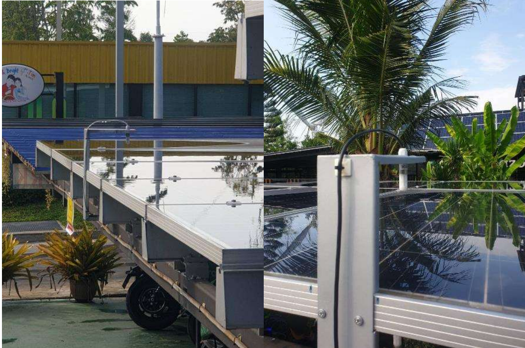
ภาพที่ 2 แผงโซลาร์เซลล์บนหลังคาอาคารจอดรถ
