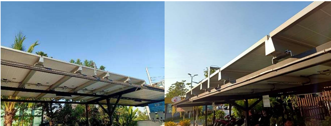
ภาพที่ 3 การยึดตัวแผงโซลาร์เซลล์กับโครงสร้างอาคารจอดรถ
