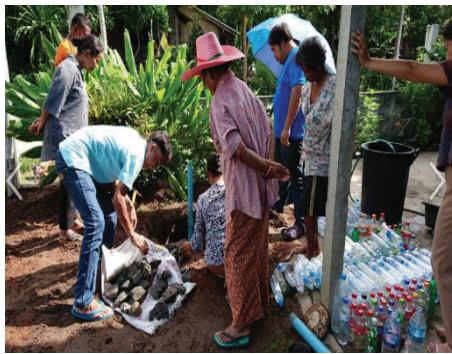
ภาพที่ 7 การฝึกปฏิบัติการการทำธนาคารน้ำใต้ดินระบบปิด
