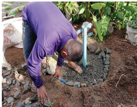
ภาพที่ 7 การฝึกปฏิบัติการการทำธนาคารน้ำใต้ดินระบบปิด
