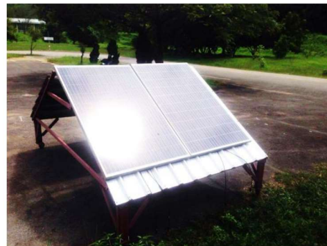
รูปที่ 14 การติดตั้งแผงเซลล์แสงอาทิตย์
