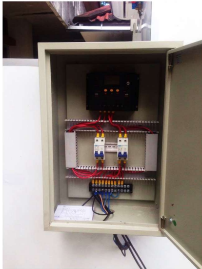
รูปที่ 15 วงจรอัดประจุแบตเตอรี่
